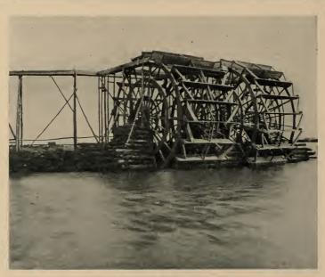
LIFTING WATER FOR IRRIGATION
